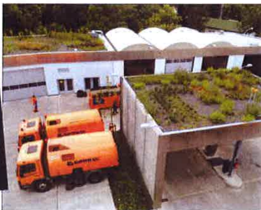
Na zeleň se nezapomnělo ani na střechách užitkových budov a čerpací stanice Foto Jan Kroupa
