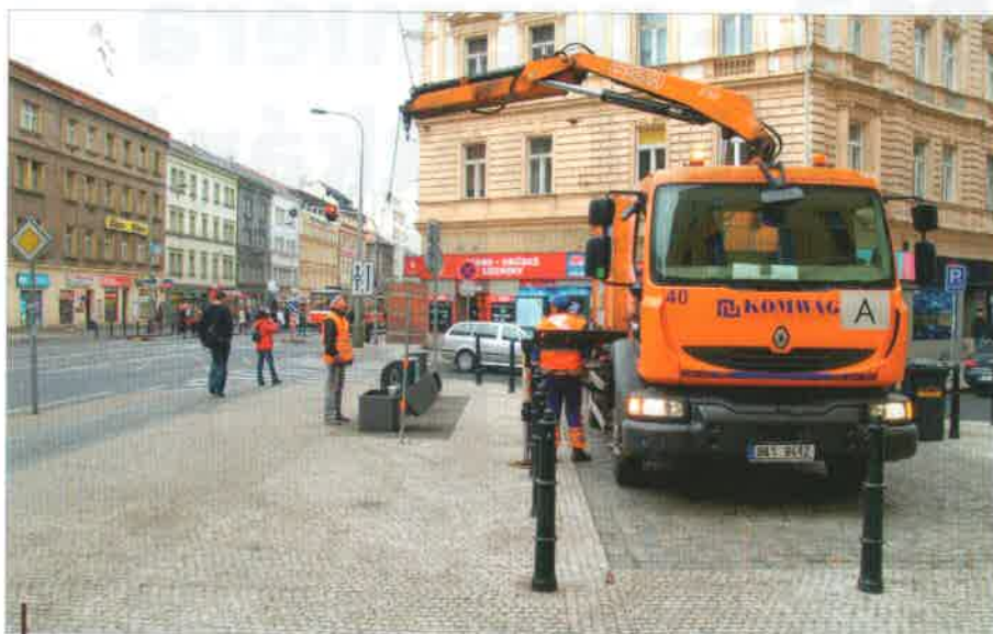
Exponované stání v ulici Francouzská po instalaci podzemních kontejnerů jednoznačně prokouklo
