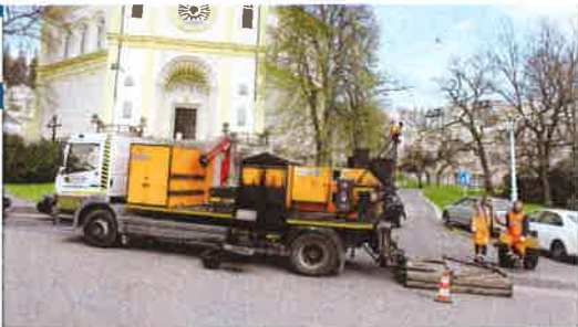
Ukázka opravy výtlučku zařízením Siltkot, kterou předvedla společnost Asfalt OK
